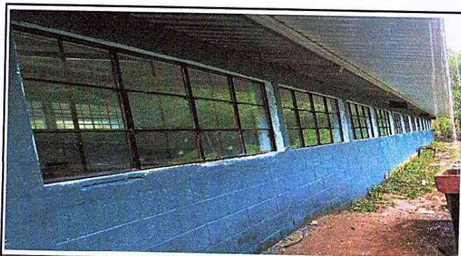
Foto 3: Culminacion en la sustitucion de estructura metalica de vidrios
