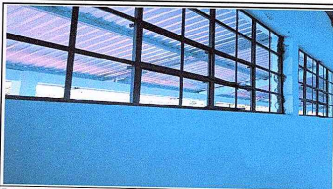
Foto 2: Culminacion en la sustitucion de vidrios que estaban en mal estado
