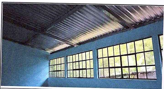
Foto 5: Culminacion de la sustitucion de costaneras a unas de metal
