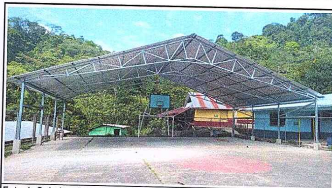
Foto 4: Culminacion en la sustitucion del entechado en cancha
